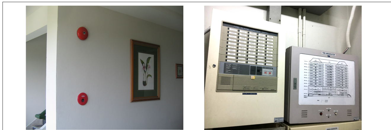
ภาพที่ 1-10 อุปกรณ์แจ้งเหตุ, แผงควบคุมระบบสัญญาณเหตุเพลิงไหม้ และแผงแสดงสัญญาณแจ้งเหตุเพลิงไหม้
