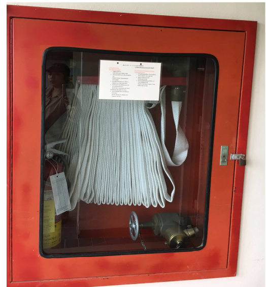
ภาพที่ 1-13 ตู้หัวฉีดน้ำดับเพลิง
